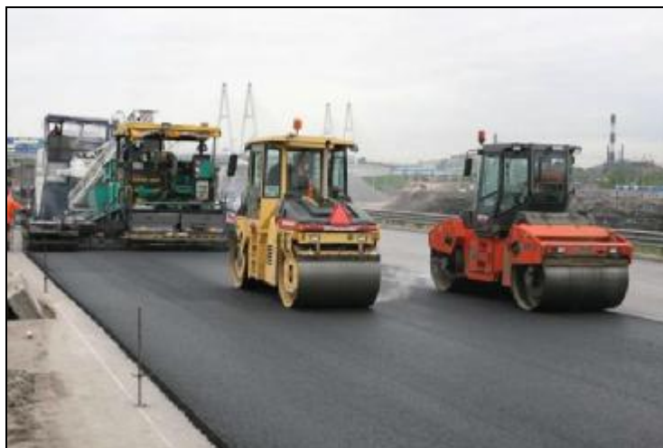
Рис. 1. Новые нано технологии для ремонта Волгоградских дорог
