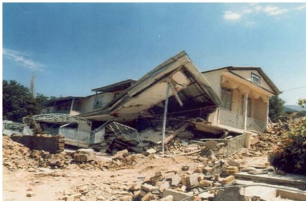
Рис. 3. Фото разрушенного жилого дома при Гилан-Зенджанском землетрясении 1990 года
