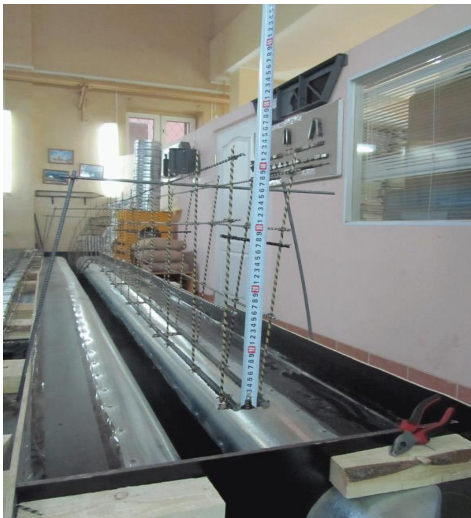
Рис. 11 «Вязка арматурного каркаса»
