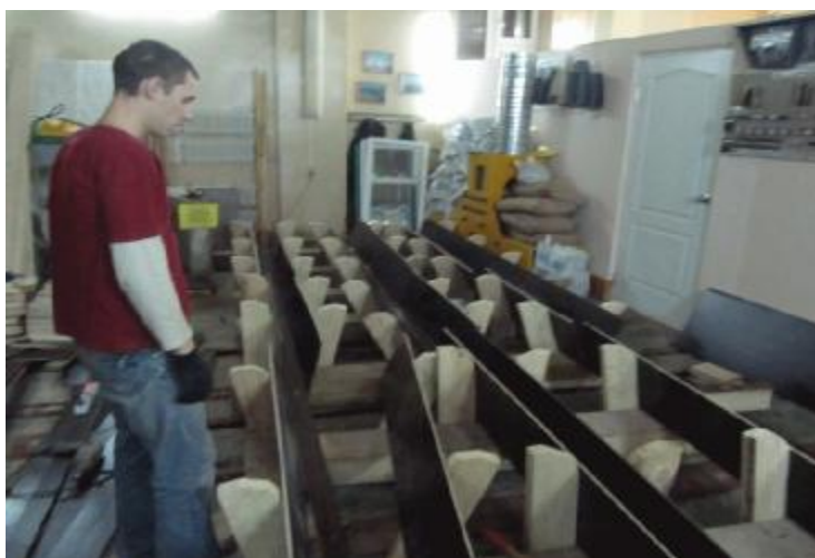
Рис. 7 «Установка стенок опалубки»
