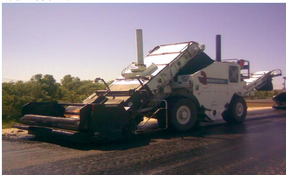
Рис.1 Устройство покрытия с использованием агрегата Шатлл-Багги
