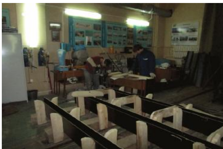
Рис. 8 «Изготовление и установка ребер»
