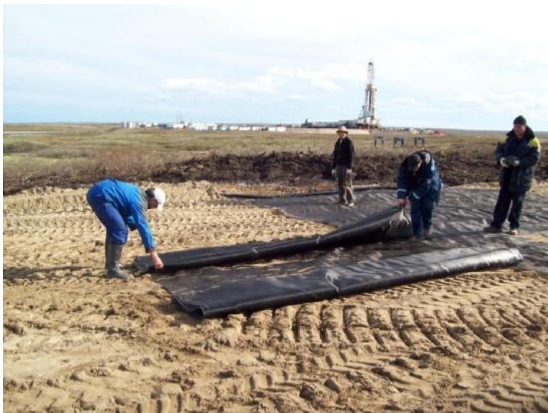
Рис. 1 Укладка геосинтетических материалов
