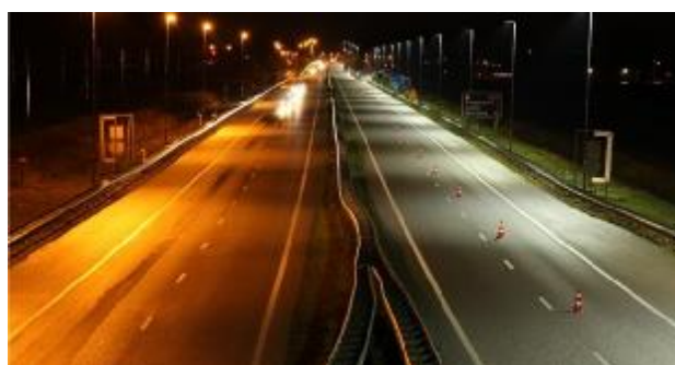
Рис.5. Освещение автомобильной дороги автономной осветительной системой М-80
