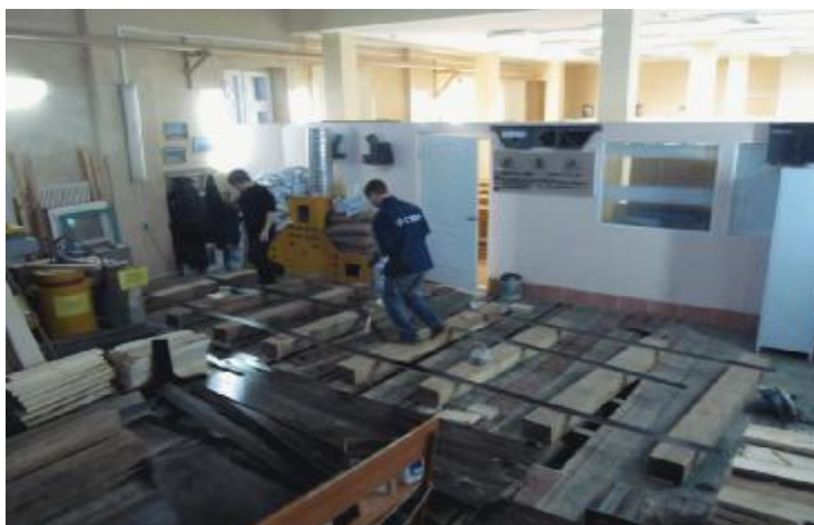
Рис. 6 «Сооружение основания опалубки»
