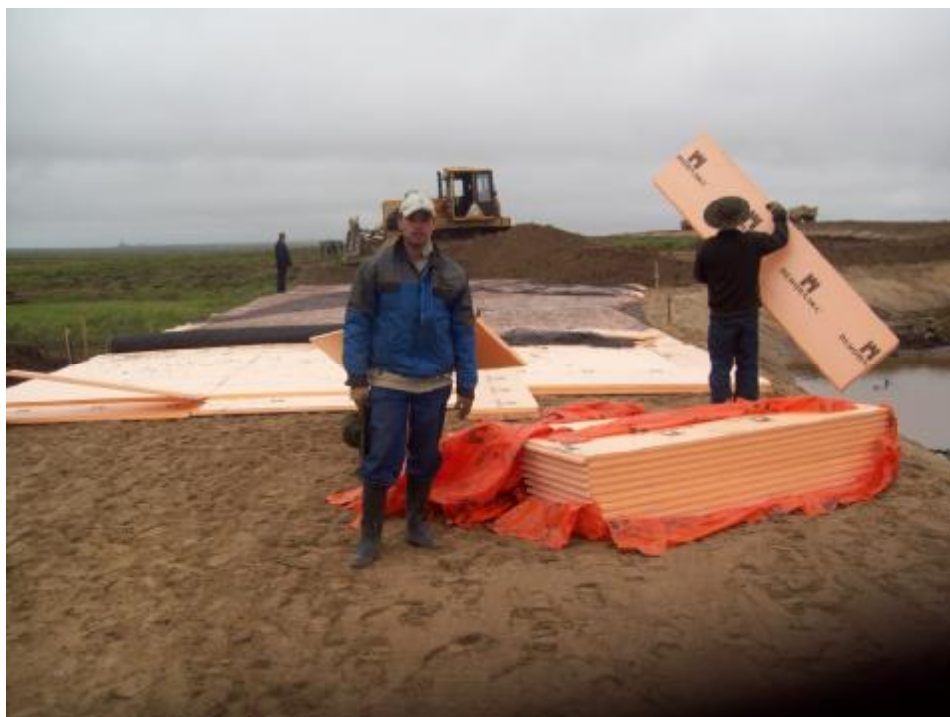
Рис. 3 Монтаж слоев теплоизоляции "Пенопелкс 45"
