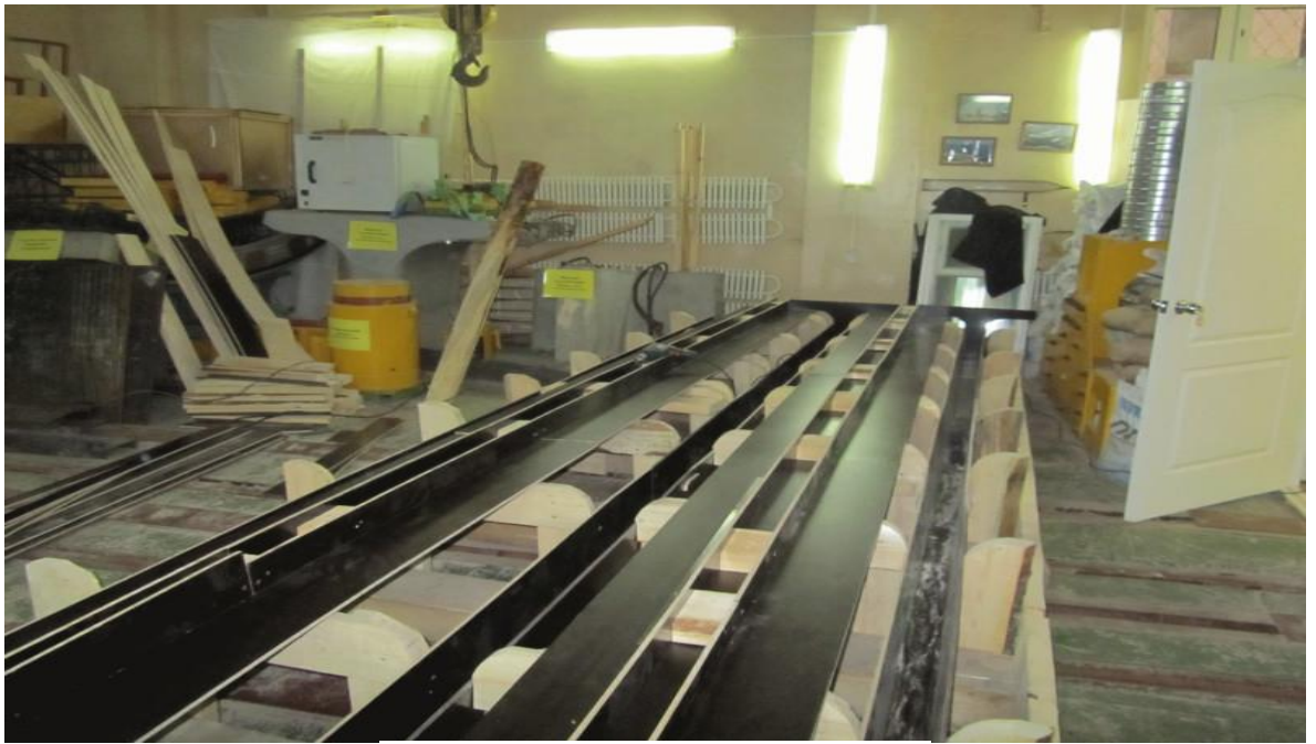
Рис. 9 «Установка полок опалубки»
