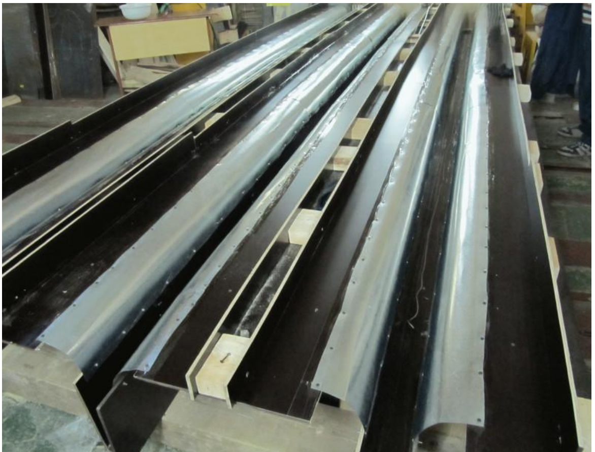
Рис. 10 «Установка вутов»
