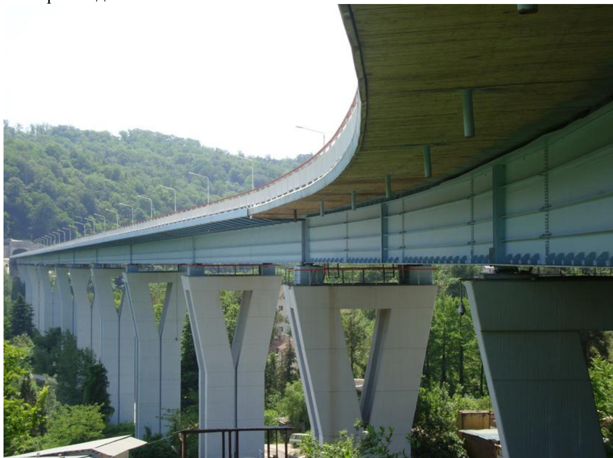
Рис. 1 Мост через реку Магеста (окраска 2000-2001 годов)
