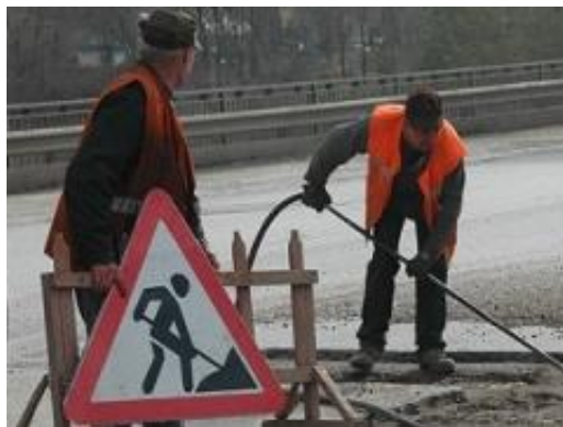
Рис. 2. Ведение ямочного ремонта на улицах Волгограда
