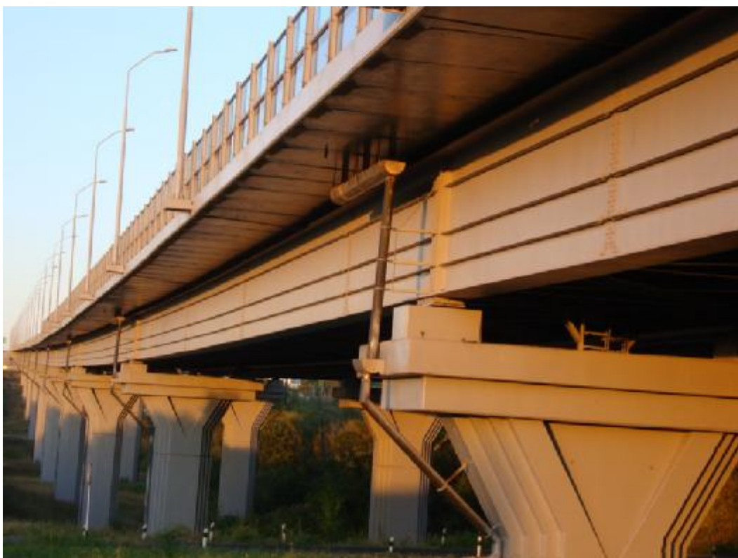
Рис. 2 Общий вид моста ч/р Гусёлка около Саратова. Системами STELPANT защищены от коррозии металлоконструкции и железобетонные опоры. Период окрашивания: I очередь – 2005 г., II очередь - 2006 г. Визуально коррозионных разрушений не обнаружено
