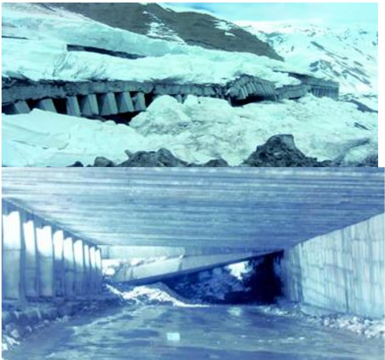
Рис. 3. Галерея, разрушенная по причине деформирования внутренней стенки колебательно-резонансными явлениями в водогрязевой массе
