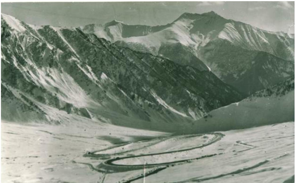
Рис. 3. Участок Транскама (32-ой км.) с максимальным уклоном 80%, минимальным радиусом на кривой (50 метров) и максимальным количеством ЧП.
