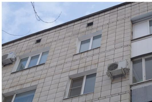
Рис. 6. Поэтажное разделение силикатной плитки ложковым рядом кирпича
