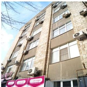
Рис. 11. Облицовка силикатной плиткой с оштукатуриванием подоконных частей
