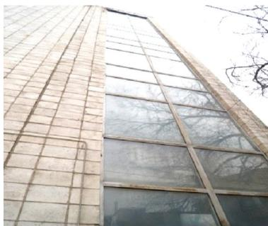
Рис. 4. Сочетание силикатной плитки с оконным витражом
