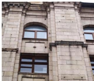
Применение силикатной плитки стало компромиссом, обеспечивающим требуемые теплотехнические характеристики. В то же время она обеспечивала эстетические характеристики внешнего вида фасадов. При строительстве в г. Волгограде были ис-
