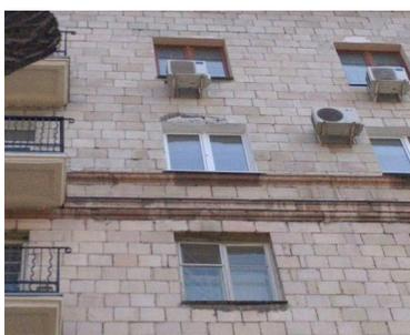
Рис. 13. Разрушение плитки при неправильной кладке
