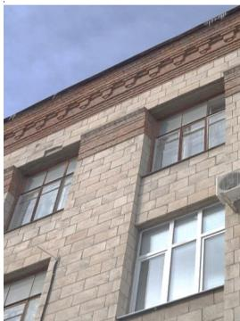
Рис. 5. Разделение силикатной плитки кирпичом
