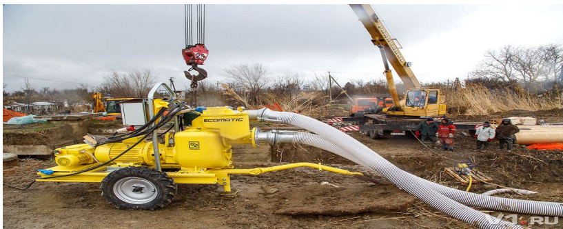
Рис. 2. Оборудование для врезки перемычек с целью регулирования потоков воды в трубопровод диаметром 1200 мм [4]
