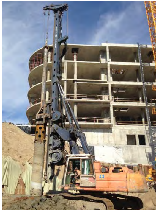
Рис. 2. Бурильная установка Gollwitzer
