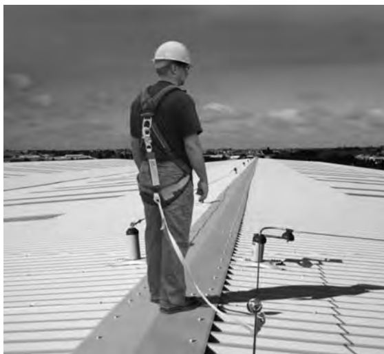
Рис. 3. Страховка на крыше
