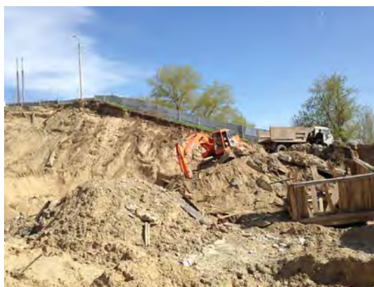
Рис. 3. Разработка грунта экскаватором Doosan
