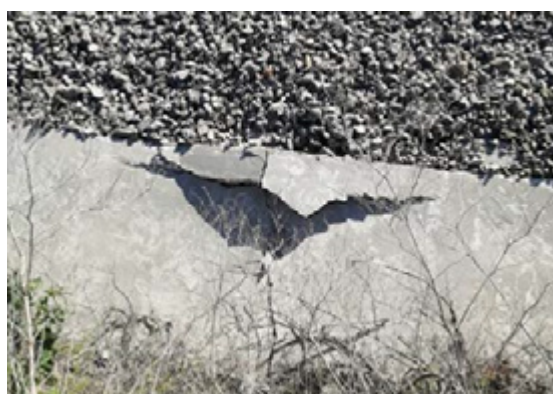
Рис. 7. Разрушения бетонной стенки водоотводной канавы
