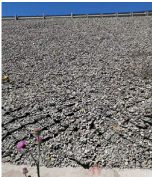
Рис. 8. Выдавливание георешетки ГЕОСПАН ОР30/15 в нижней части откоса
