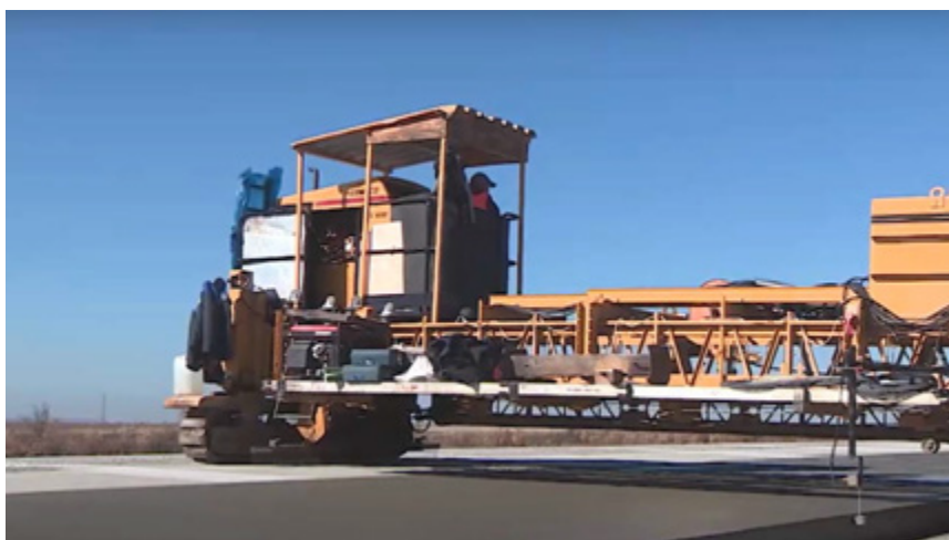
Рис. 5. Укладка смеси бетоноукладчиком GOMACO GHP-2800
