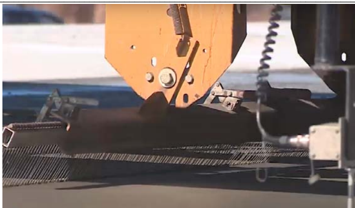
Рис. 7. Нанесение искусственной неровности на поверхность бетонного покрытия
