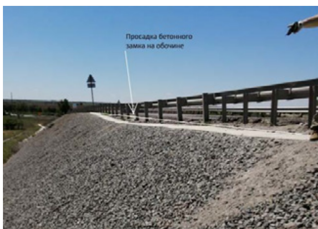
Рис. 9. Просадка бетонного замка на обочине насыпи
