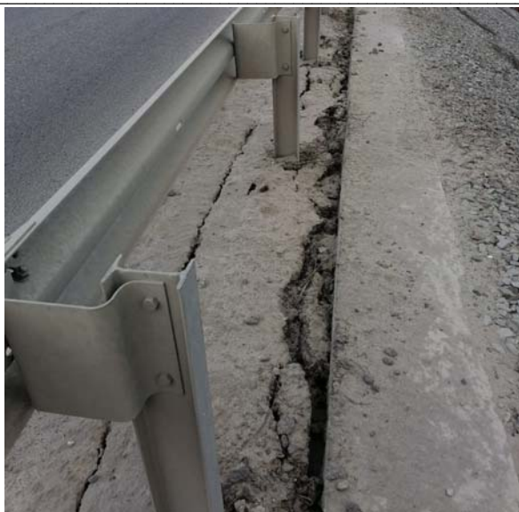
Рис. 10. Разрушения и сползание бетонного замка в сторону откоса
