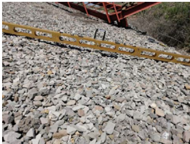
Рис. 4. Локальные просадки откоса насыпи на ПК 12 + 80
