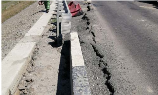
Рис. 3. Просадки обочины и проезжей части
