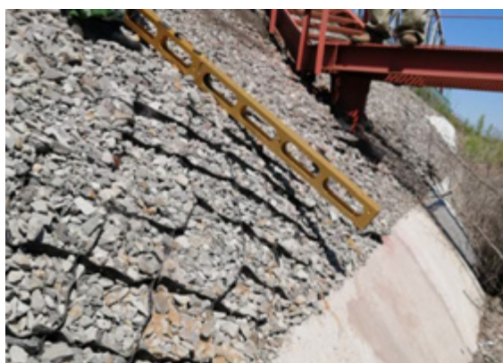
Рис. 6. Нависание грунтового массива с георешеткой над водоотводной канавой
