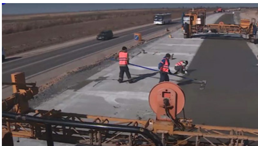
Рис. 6. Ручная отделка цементобетонного покрытия
