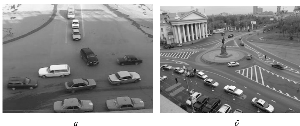
Рис. 7. Экспериментальное устройство в МКП в центральной части г. Волгограда [5]: а — до установки мини-КП, 2006 г.; б — в настоящее время после установки мини-КП
