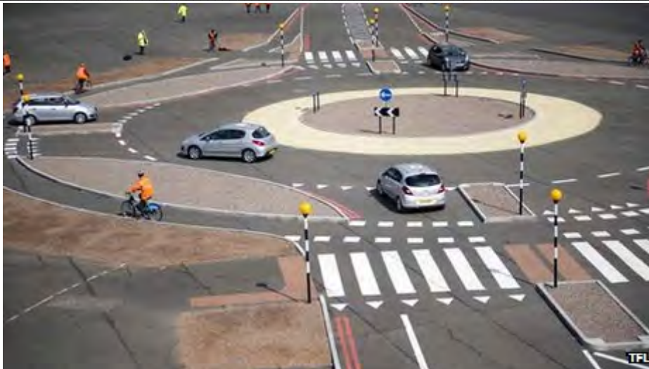
Рис. 16. Организация движения на МКП с учетом движения велосипедистов: на кольцевом перекрестке преимущество у велосипеда, а автомобили должны ждать и пропускать [27]
