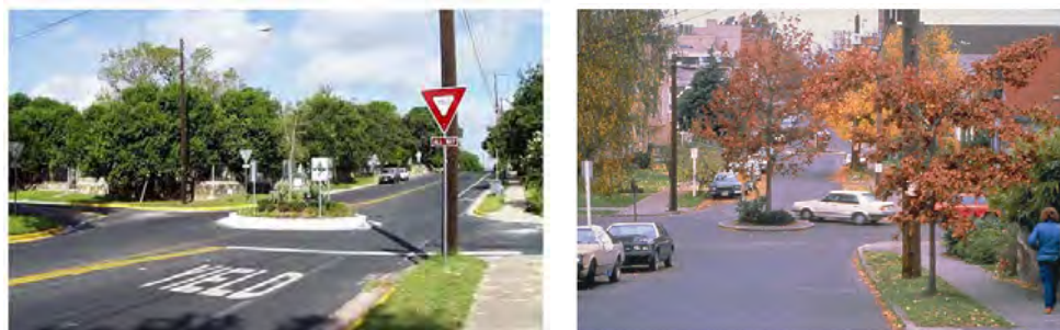
Рис. 9. Примеры мини-КП в США [11], применяемые как со знаками и разметкой, так и без них
