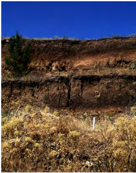
Рис. 2. Стенка срыва оползня
