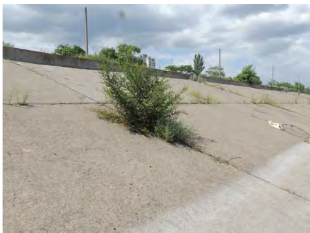
Рис. 4. Противооползневые мероприятия на Букатинском овраге
