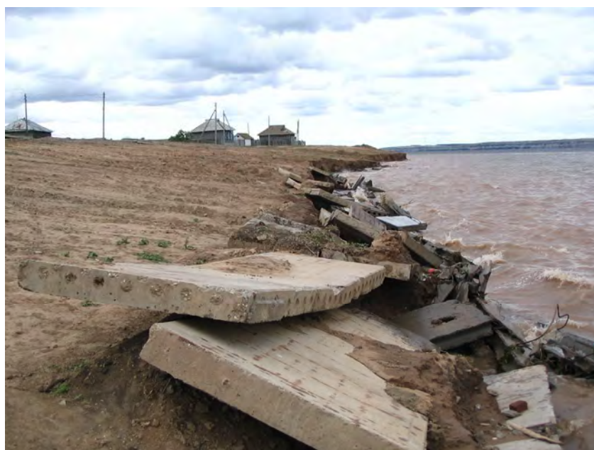
Рис. 2. Попытка укрепления берега в с. Кислово
