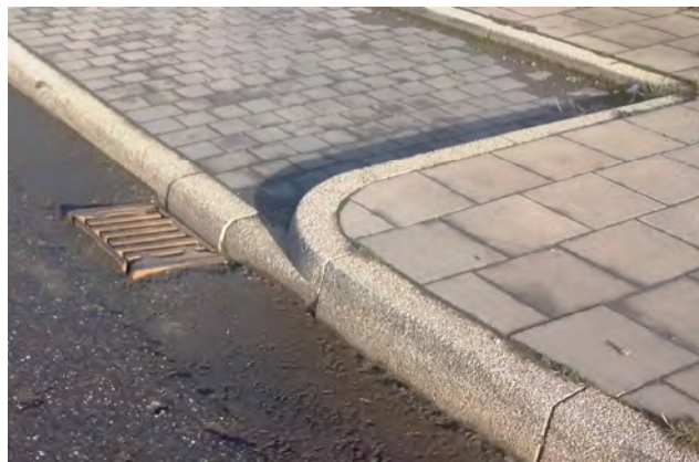
Рис. 8. Сопряжение проезжей части с парковкой бордюром
