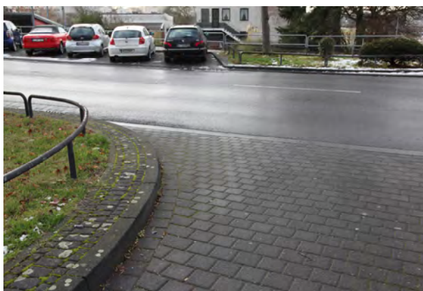
Рис. 10. Сопряжение парковки с проезжей частью закруглением
