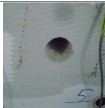
Рис. 2. Отбор проб из фрагмента стеновой конструкции [13]
