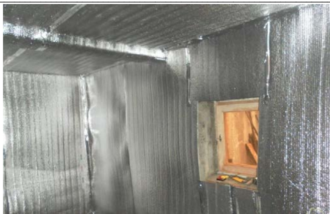
Рис. 4. Теплоизоляция помещений фольгированным материалом
