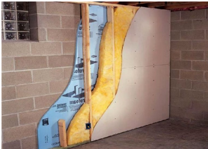
Рис. 2. Вариант утепления стен
