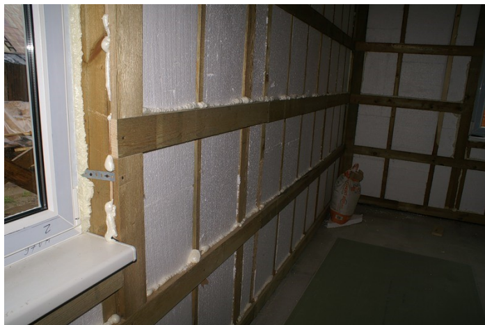
Рис. 3. Утепление стен пенопластом внутри помещений
