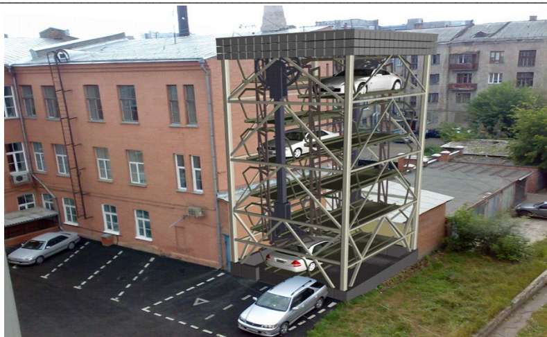
Рис. 4. Элеваторная парковка в г. Красноярске по адресу пр. Свободный, 75
