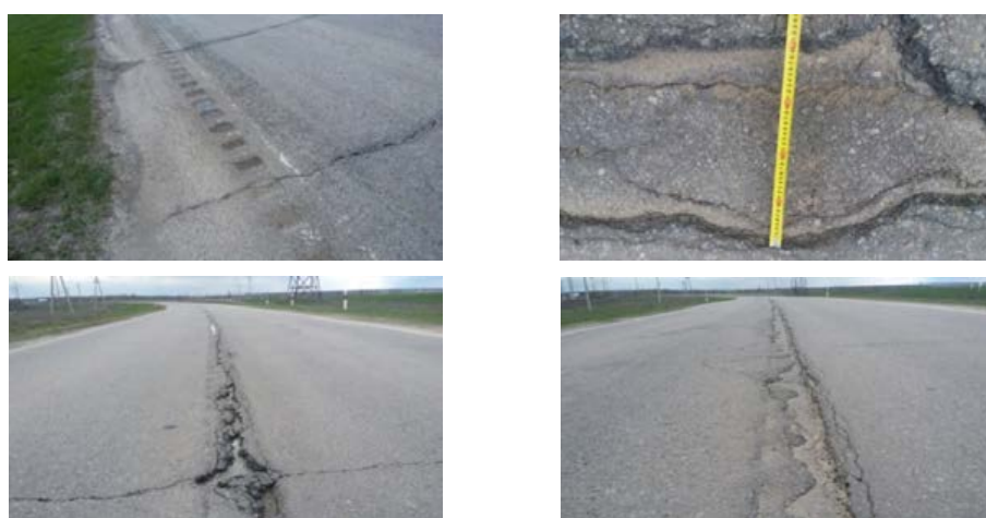
Рис. 4. Дефекты шумовой полосы (фото Г. В. Скрылева)
