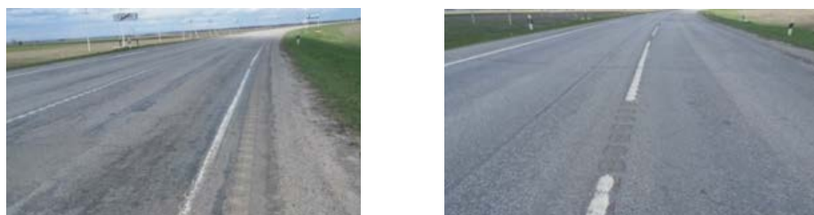
Рис. 3. Использование шумовой полосы совместно с ГДР в Дубовском районе Ростовской области (фото Г. В. Скрылева)
