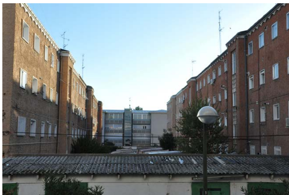
Рис. 3. Общий вид внутреннего двора (территория № 1)
