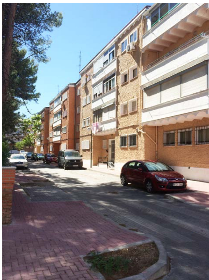
Рис. 2. Общий вид здания № 1
