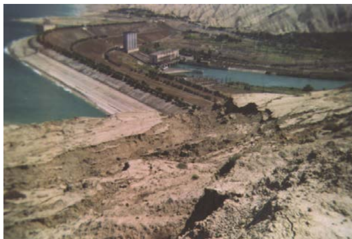
Рис. 1. Общий вид Мингечаурского водохранилища
