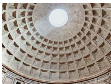
Рис. 5. Энергоэффективные системы естественного освещения зданий: а – световой колодец в Пантеоне (Рим); б – световод в покрытии современного здания
