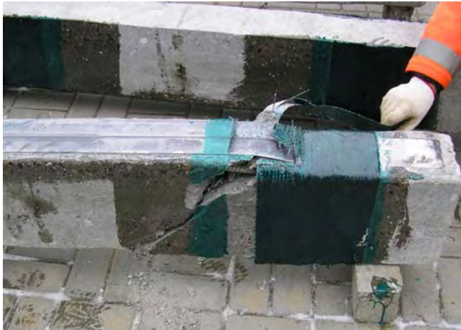
Рис. 4. Разрушение усиленной балки (образец № 3)
