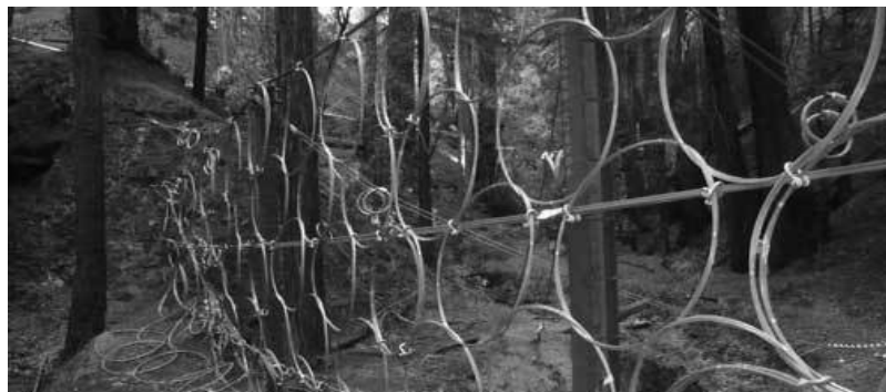
Рис. 1. Антиселевой барьер из кольчужной сетки, высокой прочности
