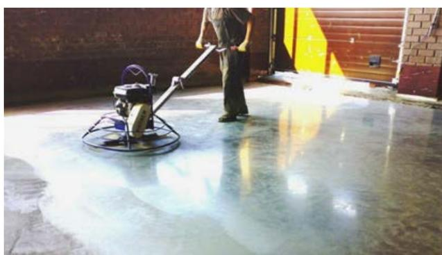
Рис. 5. Полированный топинговый бетонный пол
