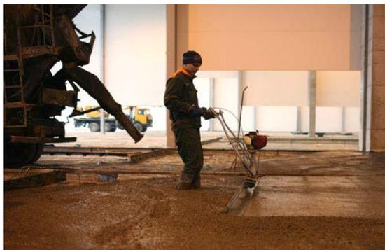
Рис. 4. Устройство бетонного пола в упрочненном верхнем слое
