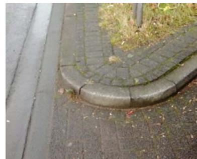
Рис. 6. Сопряжение парковки с проезжей частью  $R = 1,0$  м
