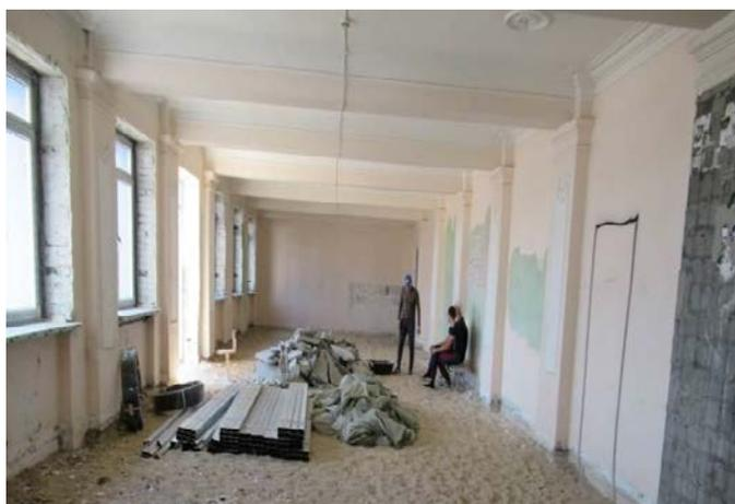
Рис. 2. Балки перекрытия БС-2 с визуально фиксируемыми прогибами
