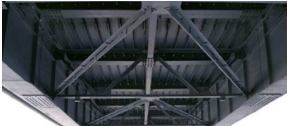
Пролетное строение с ортотропной плитой
