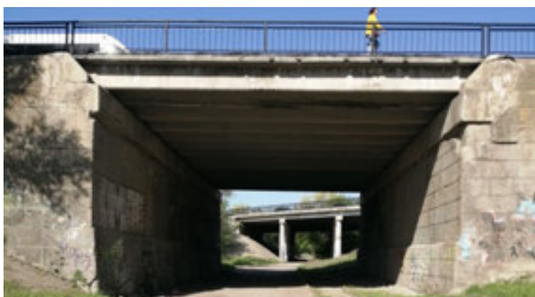
Рис. 6. Однопролетный путепровод по улице Базисной
