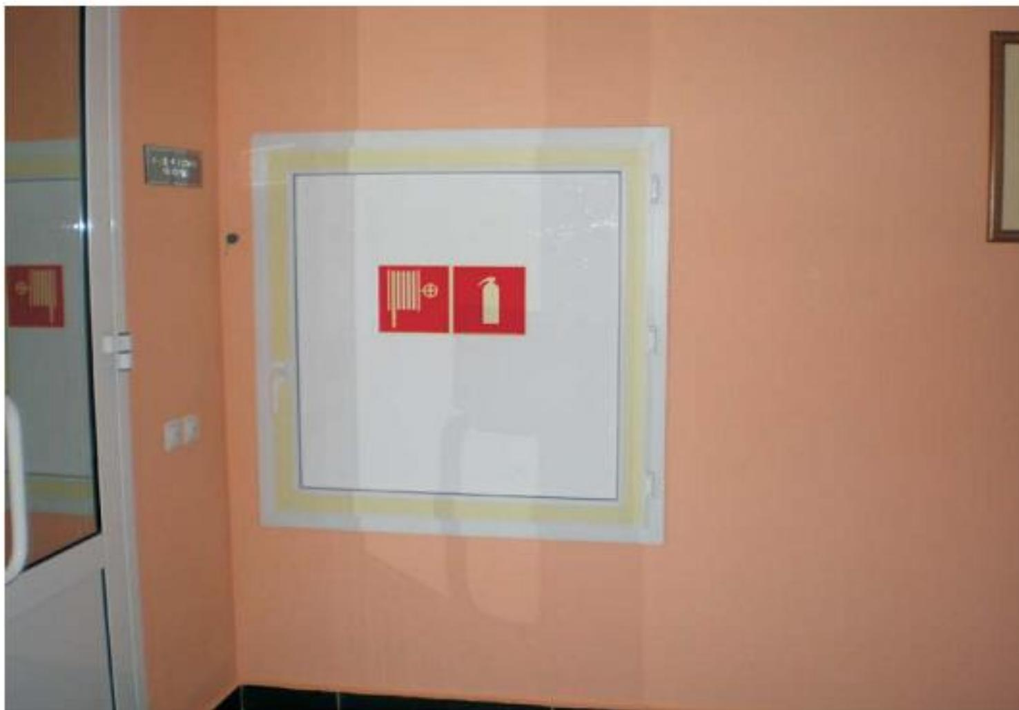
Рисунок А.6 — Обозначение фотолюминесцентной 50-мм лентой контура пожарного оборудования и использование знаков пожарной безопасности
