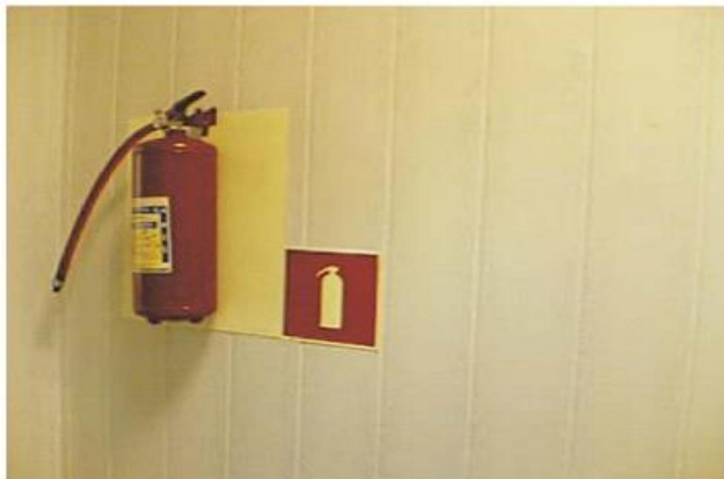
Рисунок А.7 — Вариант обозначения огнетушителя с использованием фотолюминесцентного экрана
