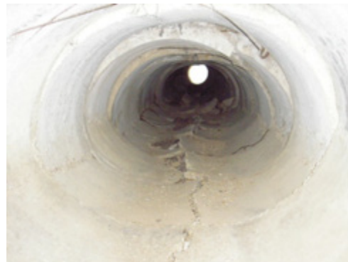
Раздавливание тела трубы
