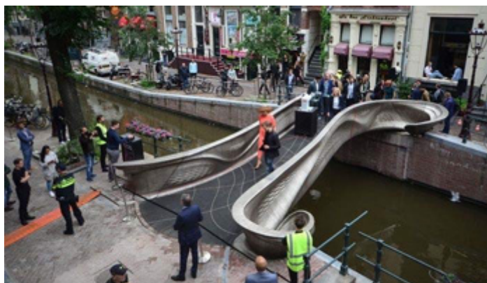
Рис. 1. Металлический мост с 3D-печатью в Амстердаме
