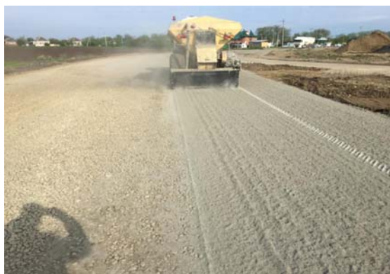
Рис. 2. Распределение по поверхности грунта неорганического вяжущего
