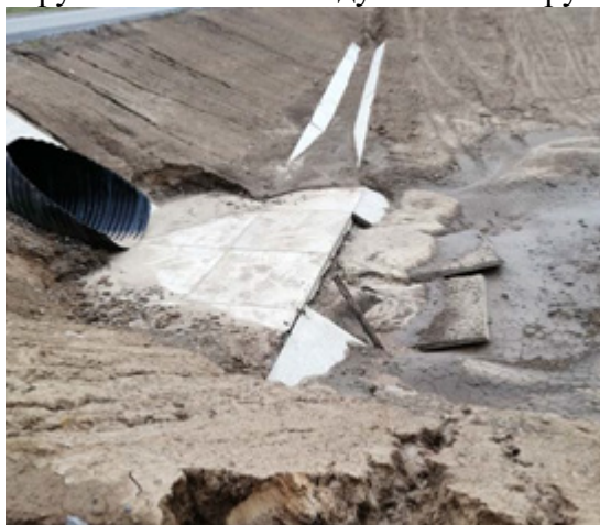
Размыв укрепления на выходе
