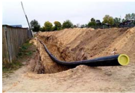
Рис. 2. Укладка полиэтиленовых труб
