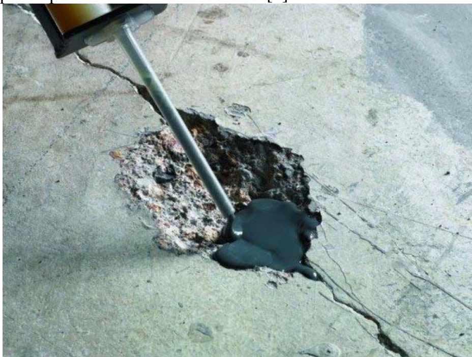
Рис. 1. Применение литьевой смеси для ремонта железобетонной конструкции
