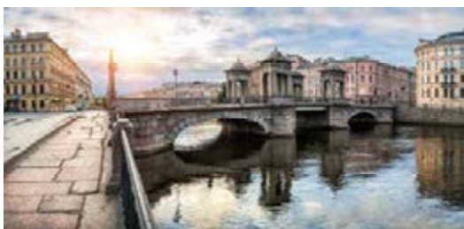
Рис. 3. Ломоносов мост в С-Петербурге. Монументальность — башни разводного пролета
