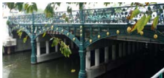
Рис. 6. Мост в Бангкоке. Декорирование — использование фальш-панелей
