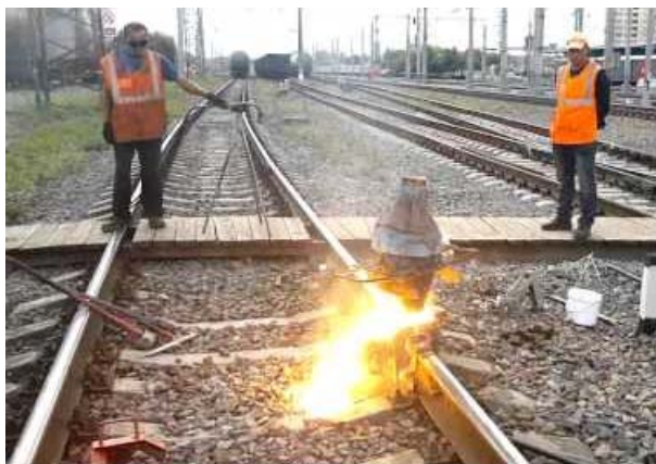
Рис. 1. Сварка рельсов в бесстыковой путь
