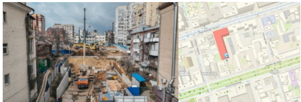
Рис. 2. Строительная площадка на ул. Пушкинская, 97, г. Ростов-на-Дону
