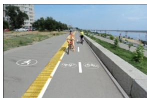
Правая сторона тротуара набережной по ул. им. Чуйкова
