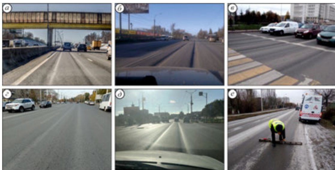
Рис. 4. Колеи на различных дорогах: а – МКАД; б – г. Самара Московское шоссе; в – г. Казань; д–е г. Омск соответственно пр-т Красный путь; ул. Дианова и ул. Д. Бедного
