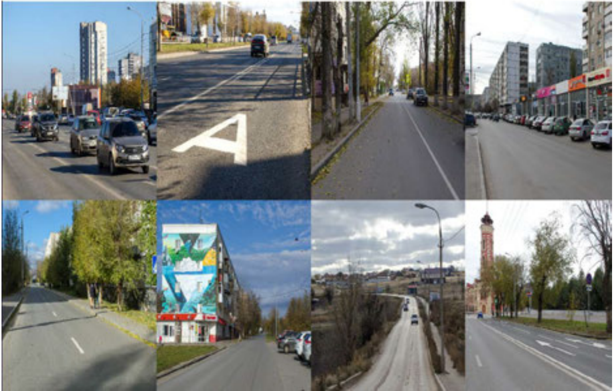
Рис.3. Отремонтированные дороги районах города Волгограда
