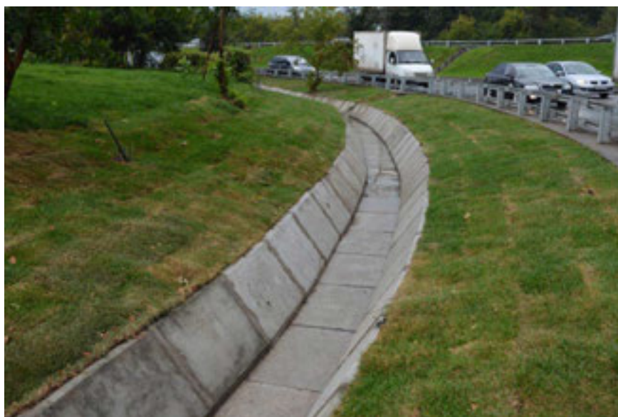
Рис. 3. Укрепление канав бетонными плитами
