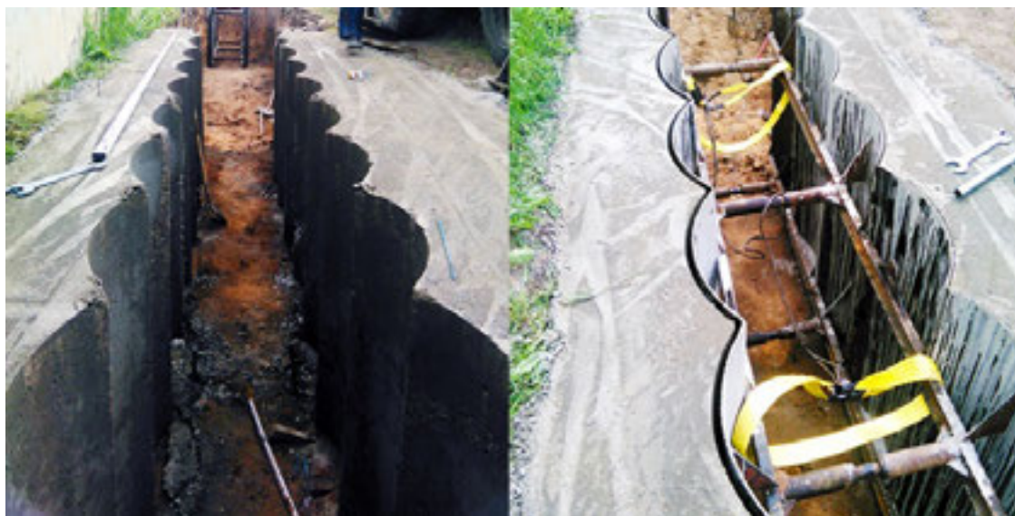
Рис. 2. Схема устройства форшахты [5]
