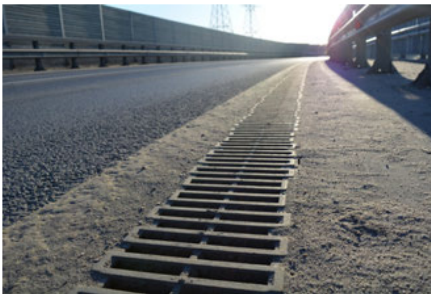
Рис. 1. Вариант реализации водоотвода
