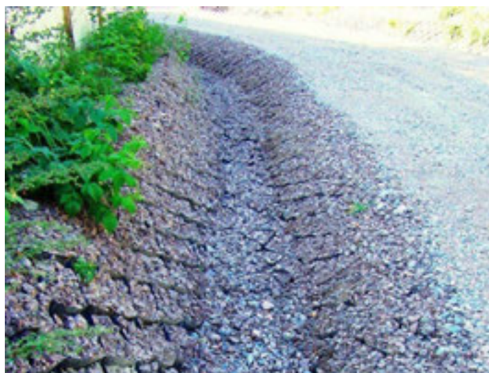
Рис. 2. Укрепление канав щебнем
