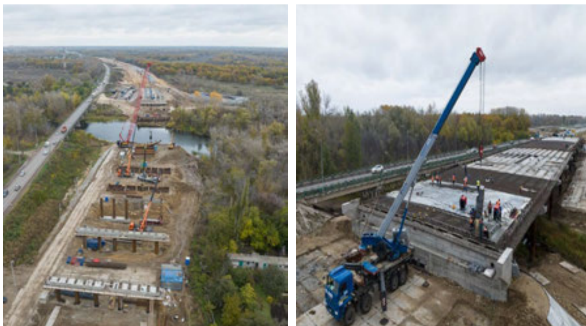
Рис. 2. Обустройство транспортной развязки около съезда на Лебяжью Поляну
