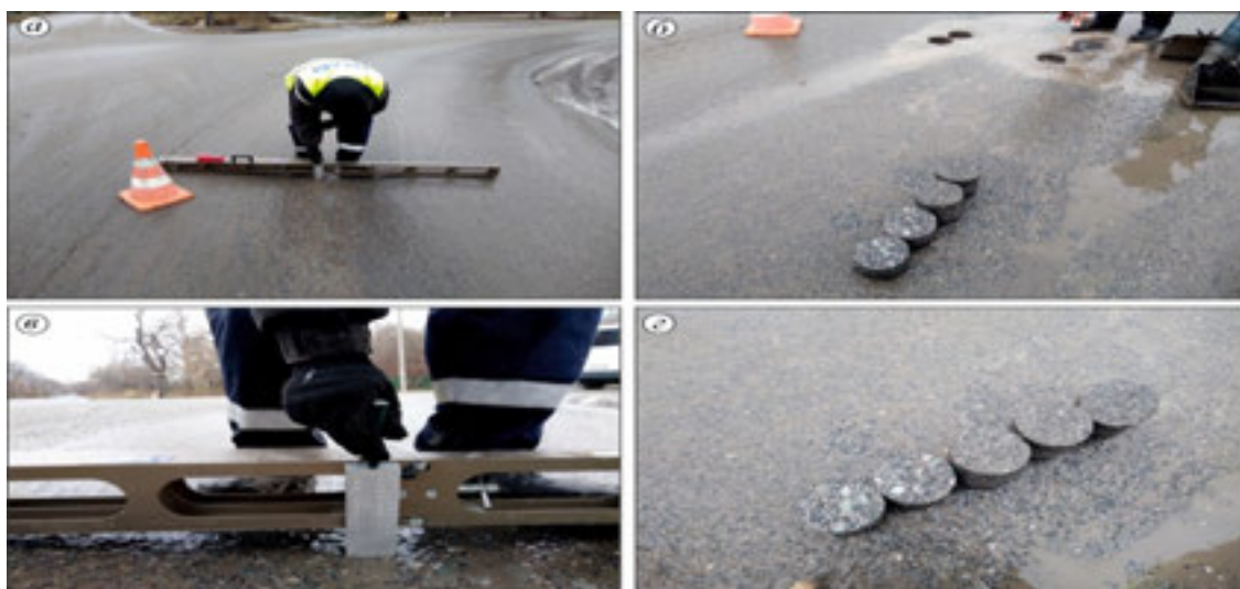
Рис. 5. Обследование колеи на дороге по ул. 1-я Чередовая в г. Омске: а – измерение глубины колеи под 2-х метровой рейкой; б – отбор кернов из колеи и между колеи; в – результат измерения глубины колеи 60 мм; г – иллюстрации различных поверхностей кернов, взятых из колеи и между колеи
