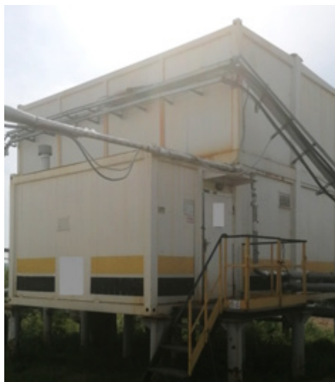
Станция биологической очистки хозяйственно-бытовых сточных вод «КСкомплект-100СК»
