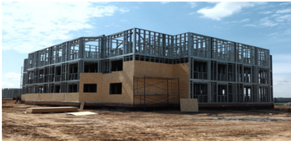
Рис. 5. Фотография объекта с площадки строительства из ЛСТК профилей ЖК «Победа», Волгоград, 2023 г.
