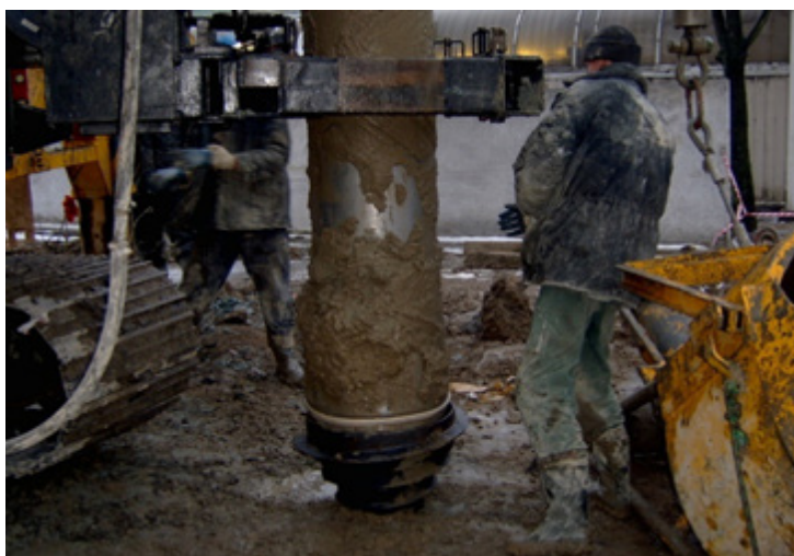
Рис. 2. Устройство свай диаметром 350 мм по технологии Fundex
