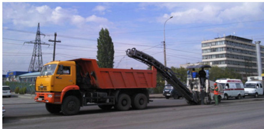
Рис. 1. Фрезерование дорожного покрытия на пр. Университетский, Волгоград
