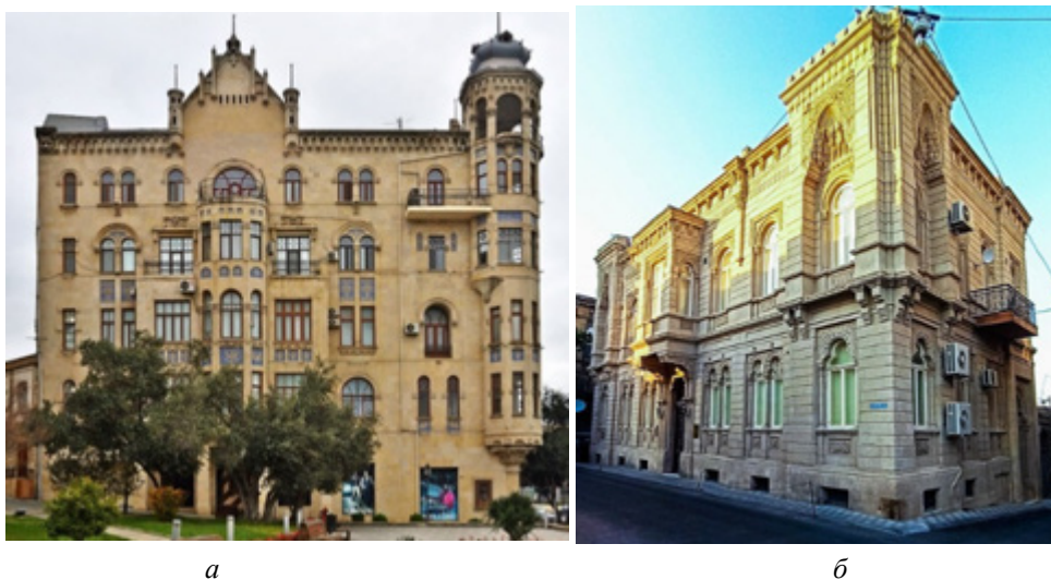
Рис. 1. Образцы архитектуры в Баку XIX—начала XX вв.: а — дом Иса-бея Гаджинского, 1912 г.; б — дом Агабалы Гулиева, 1899 г., архитектор Я. Я. Скибинский
