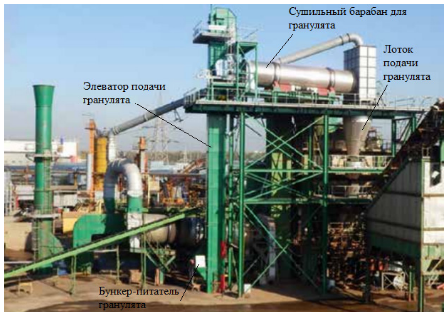
Рис. 14. Асфальтосмесительная установка циклического действия со сдвоенным сушильным барабаном, АБЗ-4 «Капотня», Москва
