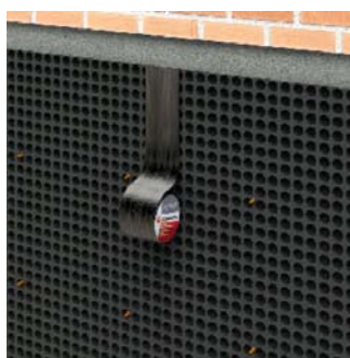
Рис.1. Проклейка швов между мембранами
