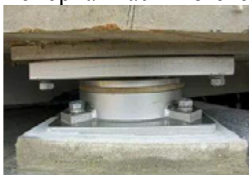
Рис. 2: а – высокомоульный полиэтилен; б – опорная часть.
