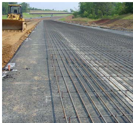
Рис. 2. Процесс строительства дорог из цемента и арматуры
