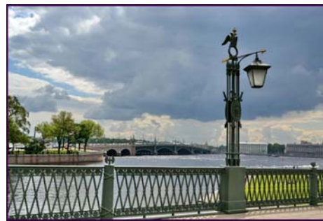
Рис. 2. Украшение Иоанновского моста фонарями и перильными ограждениями
