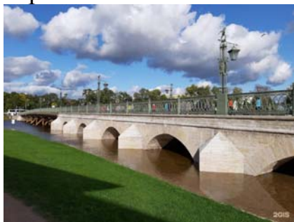
Рис.1. Прибрежные каменные устои Иоанновского моста
