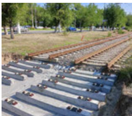
Рис. 1. Укладка рельсов
