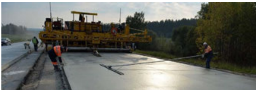
Рис. 1. Укладка цементобетонного покрытия
