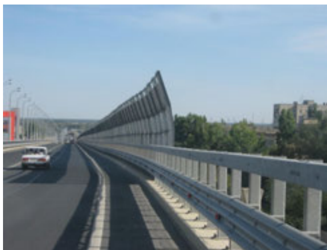
Рис. 1. Шумозащитный экран охватывающего типа на правобережном подходе к мостовому переходу через реку Волга в Волгограде
