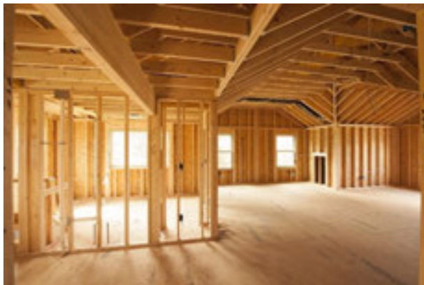
Рис. 1. Конструкция каркасного здания
