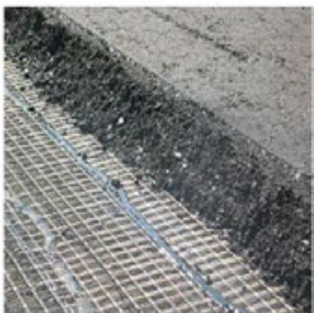
Рис. 2. Схема армирования покрытия при ремонте проезжей части
