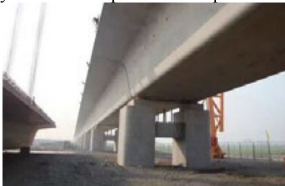
Рис. 1. Место соединения с мостовой опорой
