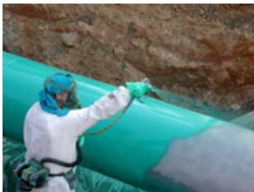
Рис. 1. Нанесение традиционного покрытия с использованием ЛОС
