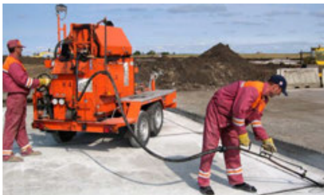
Рис. 2. Заливка швов мастикой
