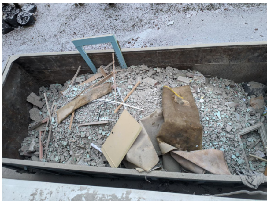
Рис. 1. Контейнеры для сбора отходов ремонтно-строительного процесса
