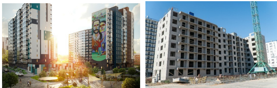
Рис. 2. Объект исследования: строительная площадка 14-этажного многоквартирного жилого дома
