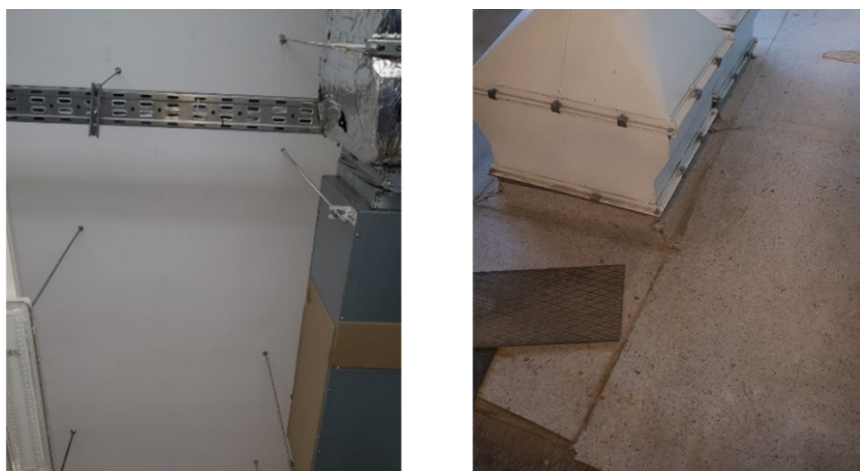
Рис. 1. Общий вид участка перекрытия
