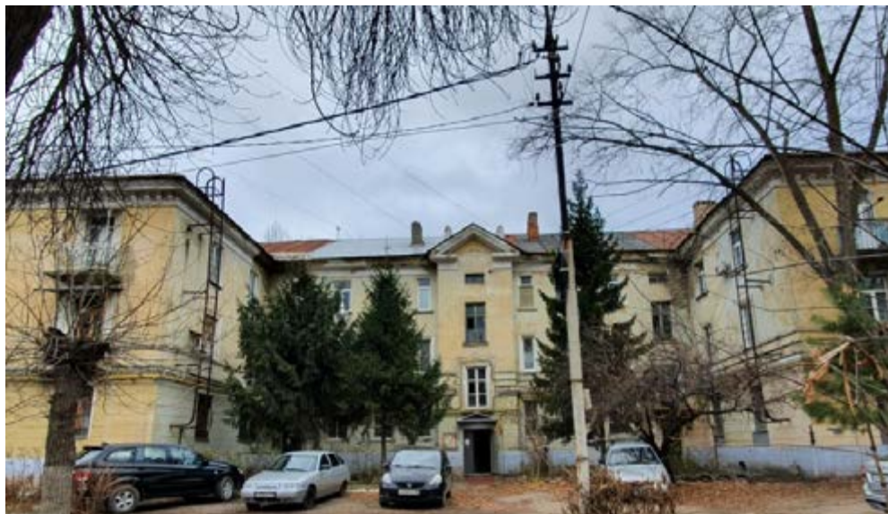
Рис. 2. Дом жилой, расположенный по ул. З. Космодемьянской, 16, г. Саратов, северо-восточный фасад (дворовой), архитектор Н. К. Усов
