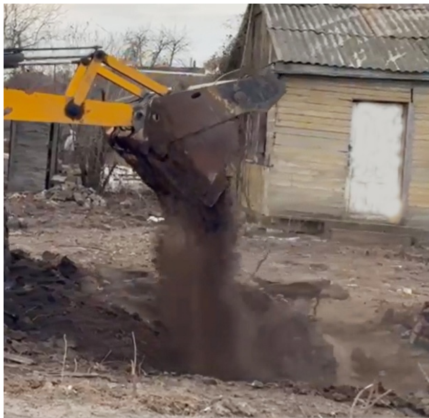
Рис. 2. Технологическая операция отсыпки грунта, сопровождающаяся выделением пыли
