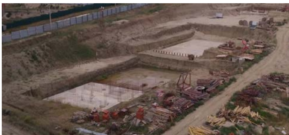
Рис. 7. Здание ЖК «Колизей» на этапе устройства фундамента
