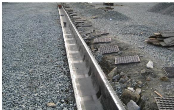
Рис. 1. Устройство водоотводного лотка
