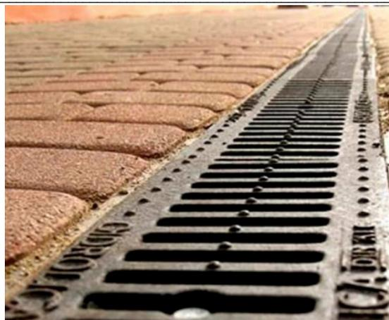
Рис. 2. Устройство ливневой канализации
