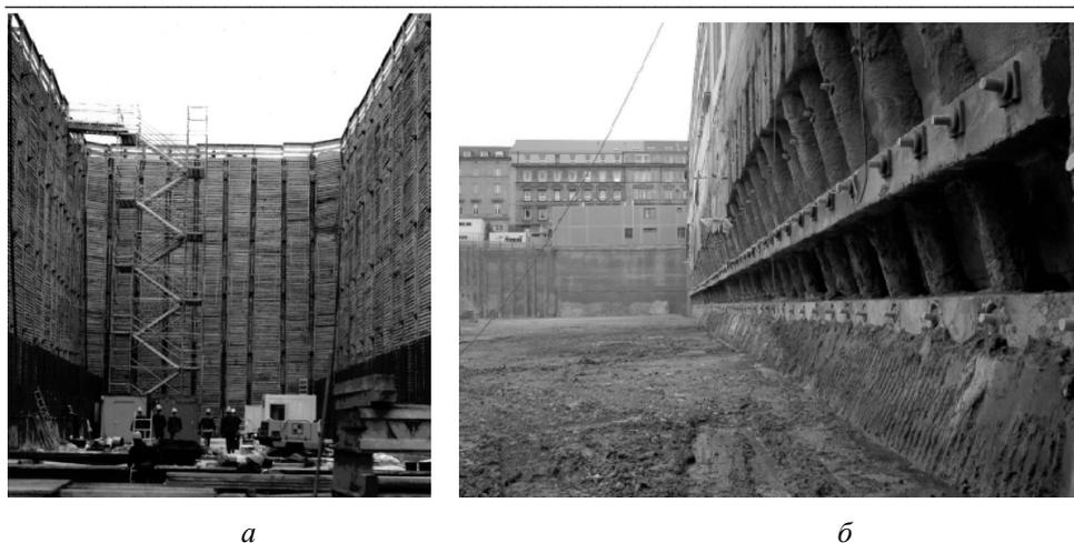
Рис. 1. Ограждающая конструкция глубокого котлована:
