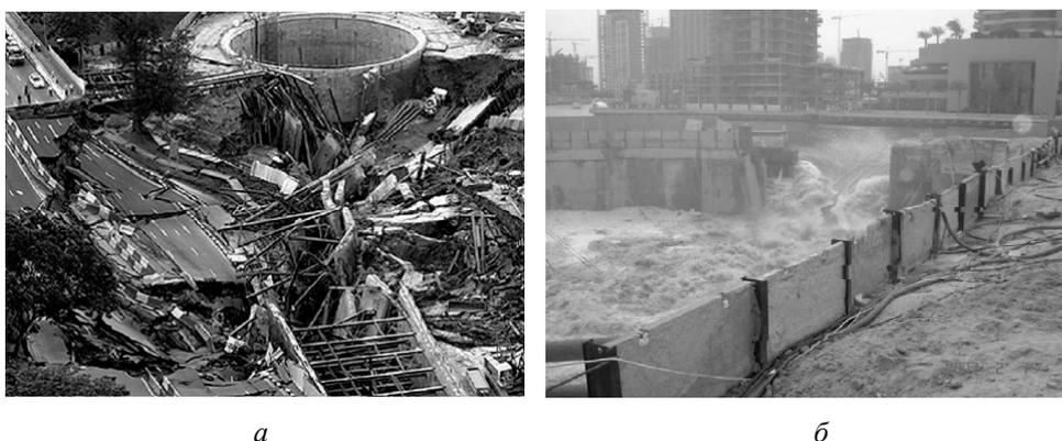
Рис. 2. Разрушение ограждающей конструкции котлована, выполненной методом Top-Down: *a* — при строительстве кольцевой дороги в Сингапуре; *б* — жилого здания в Дубаи [1]
