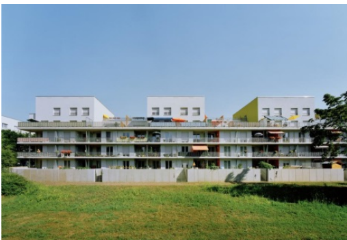
Рис. 7. Пример увеличения площади квартир за счет устройства приставных балконов и открытых террас
