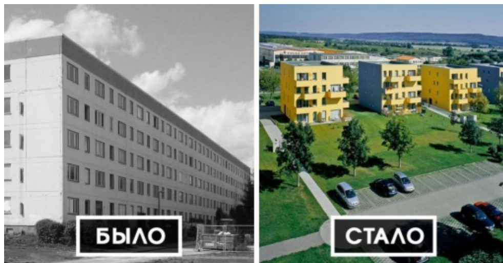
Рис. 4. Панельное здание в Германии до и после модернизации
