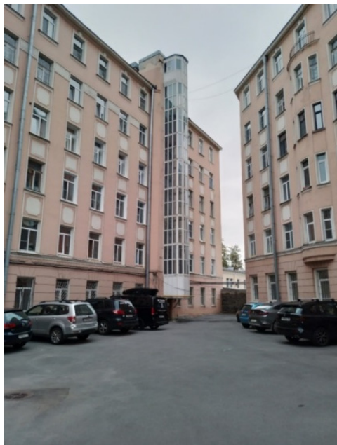
Рис. 2. Навесной лифт в многоквартирном жилом доме по адресу: Санкт-Петербург, пер. Бойцова, 4
