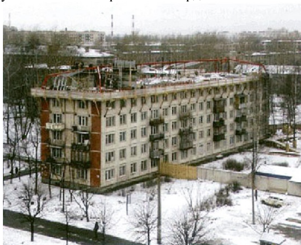
Рис. 9. Многоквартирный панельный жилой дом по адресу: ул. Торжковская, 16, в период реконструкции
