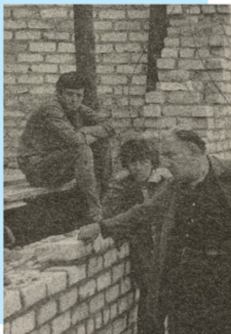
И.П.Савченко на строительстве нового корпуса (Б) института.
