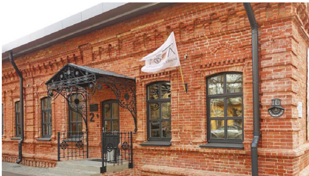
Рис. 6. Здание «Лофт 1890» после реконструкции. Главный фасад
