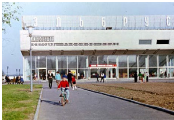
Рис. 7. Кинотеатр «Эльбрус» до реконструкции. Главный фасад
