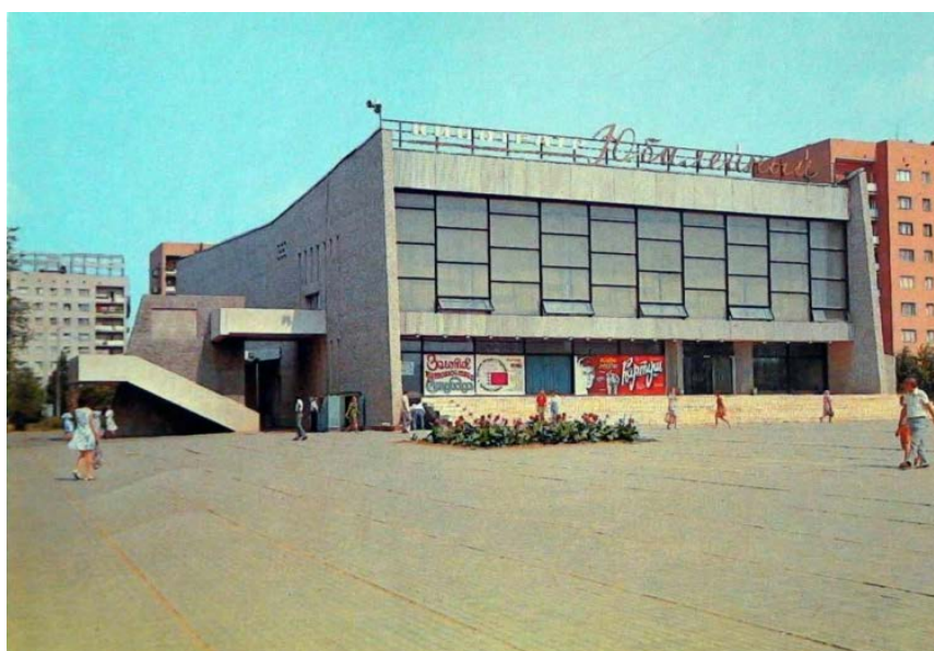
Рис. 5. Изначальный облик здания кинотеатра «Юбилейный»
