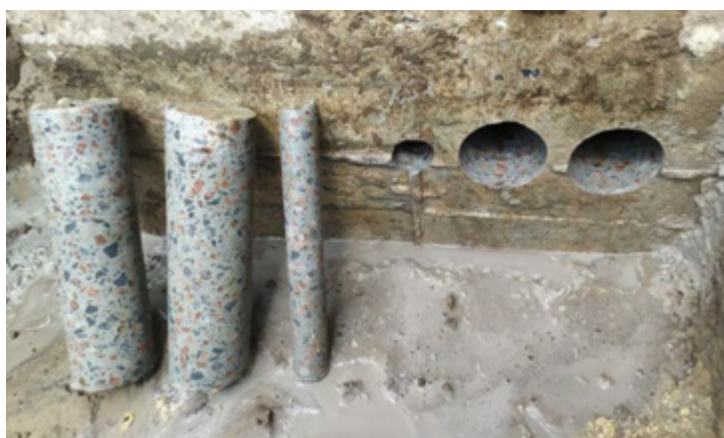
Рис. 2. Выбуривание кернов из конструкции
