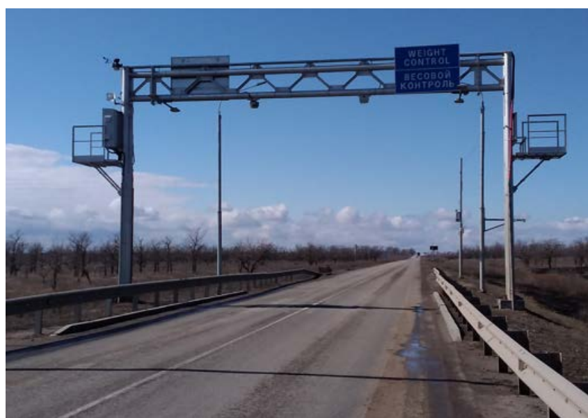
Автоматический пункт весогабаритного контроля транспортных средств, размещенный на автомобильной дороге Волгоград — Котельниково — Зимовники — Сальск в Волгоградской области
