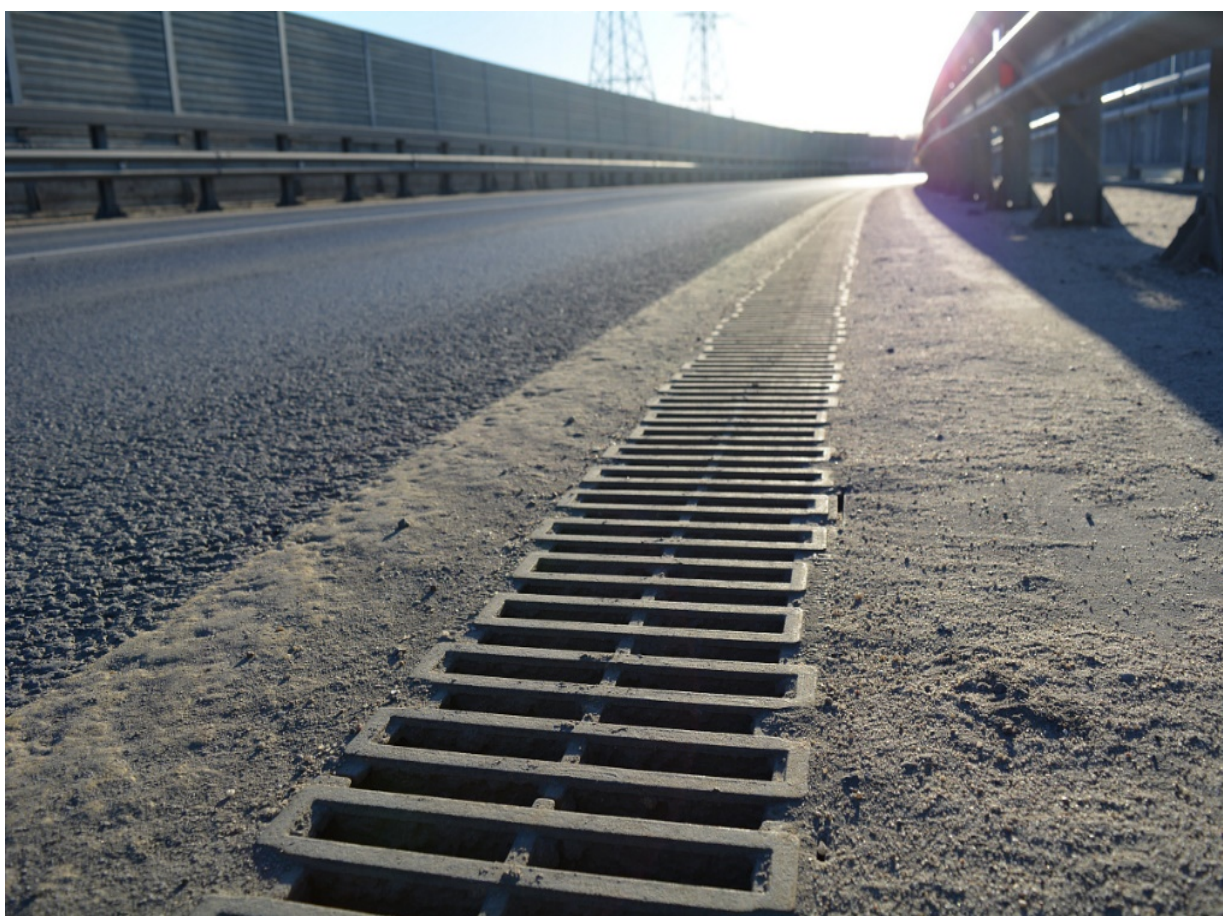
Вариант реализации водоотвода
