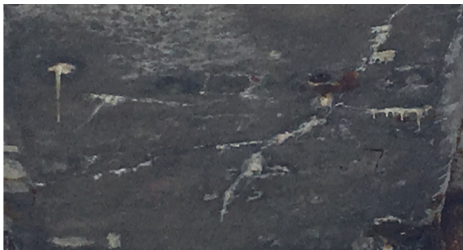
Рис. 3. Кальциевые сосульки — сталактиты на плите проезжей части
