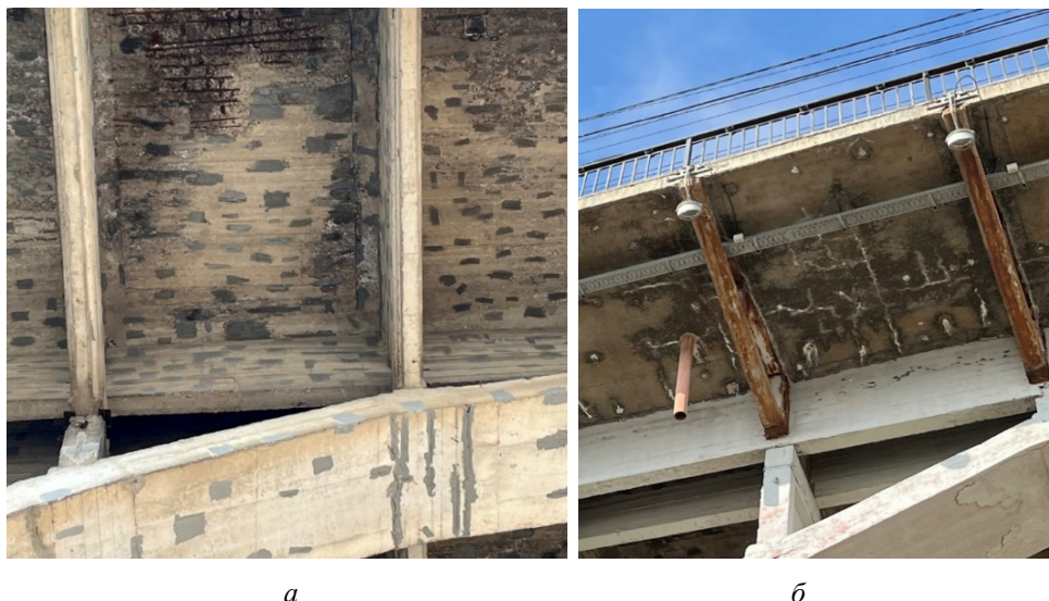
Рис. 2. Коррозионные процессы в плите проезжей части: а — карбонизация бетона плиты проезжей части, разрушение защитного слоя бетона, обнажение и коррозия арматуры; б — трещины в тротуарной консоли, высолы, образование карбонатов, коррозия стальных кронштейнов
