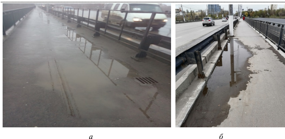
Рис. 4. Вода на тротуаре моста: а — отсутствуют уклоны; б — нет водоотвода с тротуара
