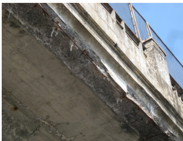
Рис. 6. Пролет 2. Главная балка 1. Фасад. Консольная плита. Фасад. Деградационное разрушение бетона с обнажением арматуры. На 1/3 длины пролета
