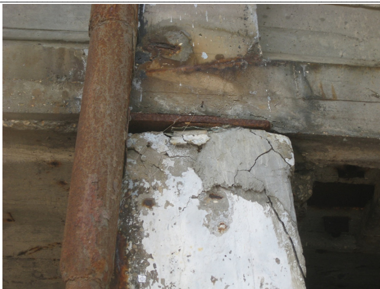
Рис. 7. Опора 4. Главная балка 1. Опорная часть. Верхний пояс. Разрушение бетона в результате заклинки конструкции
