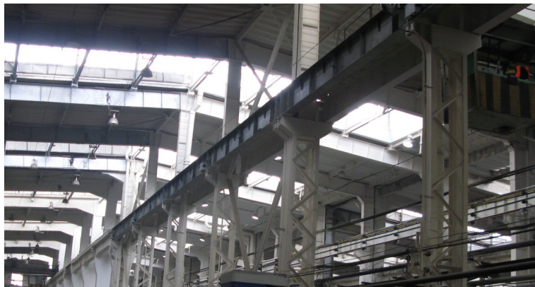
Рис. 6. Восстановленные стальные колонны и подкрановые балки взамен разрушенных железобетонных
