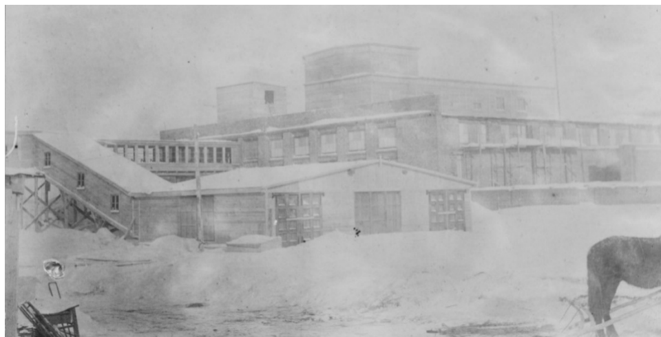
Рис. 2. Строительство завода демпферного гипса, 1943 г. (ЦГАСО, ф. Р-3985, оп. 2, д. 10)
