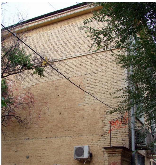
Рис. 5. Торцевая часть жилого дома (ОКН) по адресу г. Волгоград, ул. Баррикадная, д. 22 со стороны ул. Социалистической 2
