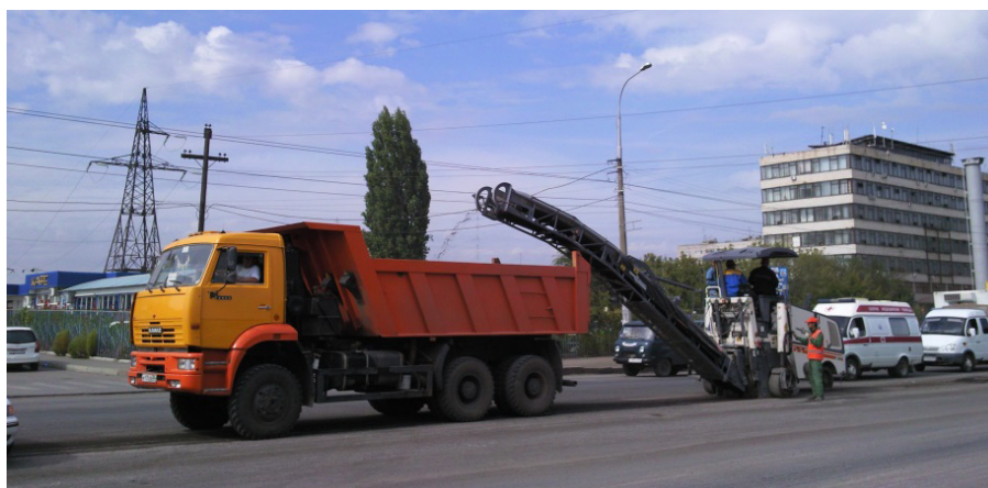
Рис. 1. Фрезерование дорожного покрытия на пр. Университетский, Волгоград
