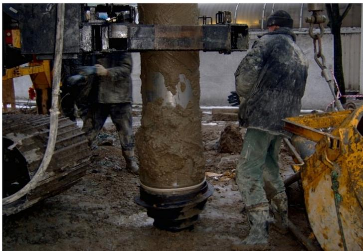
Рис. 2. Устройство свай диаметром 350 мм по технологии Fundex
