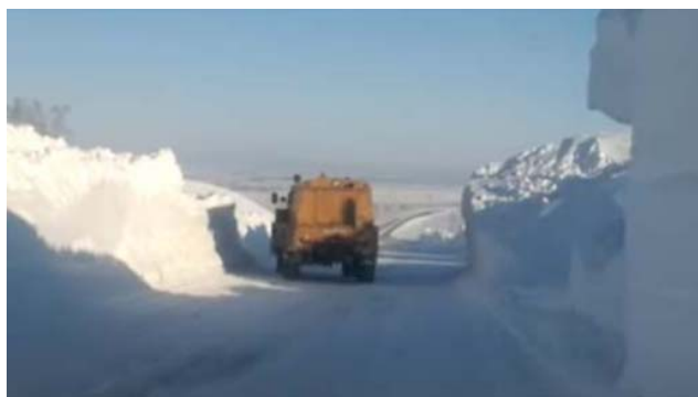
Рис. 1. Заносы снега на автомобильной дороге Р-228 в январе 2022 г
