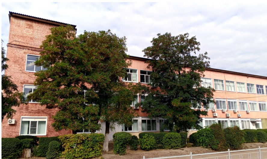
Рис. 3. Вид на второй корпус АБК
