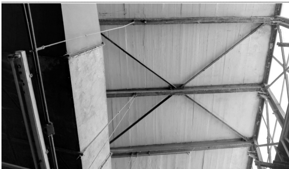
Рис. 8. Металлические связи, вид снизу
