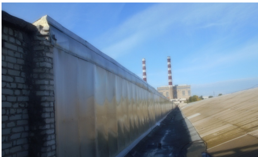
Рис. 14. Фрагмент устройства крыши типа «шед»
