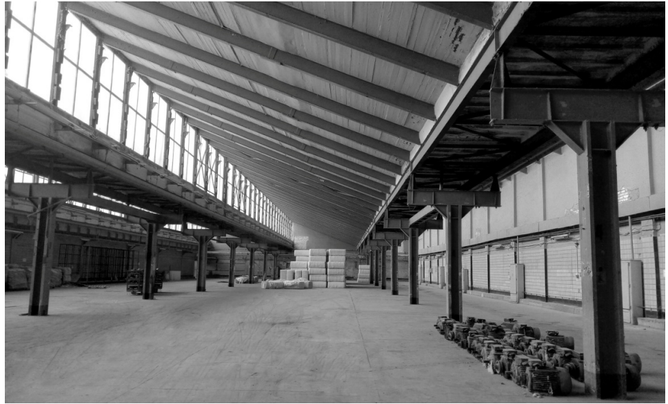
Рис. 5. Металлический каркас устройства шедов (зона складирования прядильного производства)
