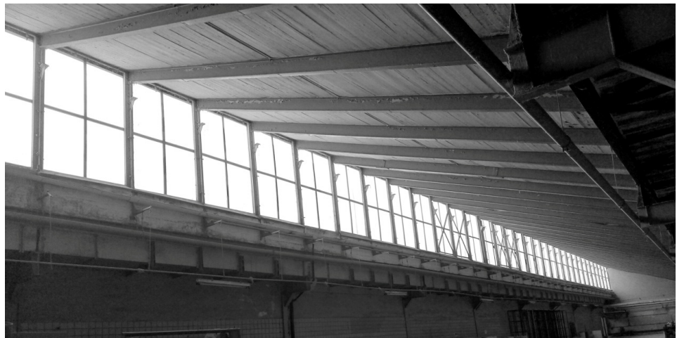
Рис. 6. Устройство шедов и окон фонарей
