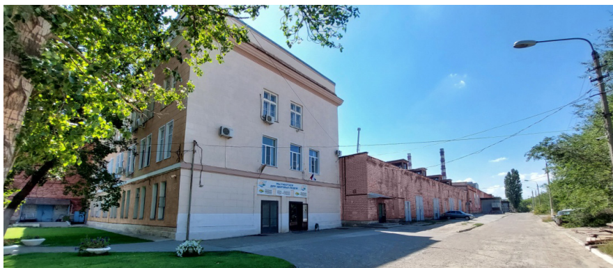
Рис. 2. Вид на первый корпус АБК ткацкого производства с боку
