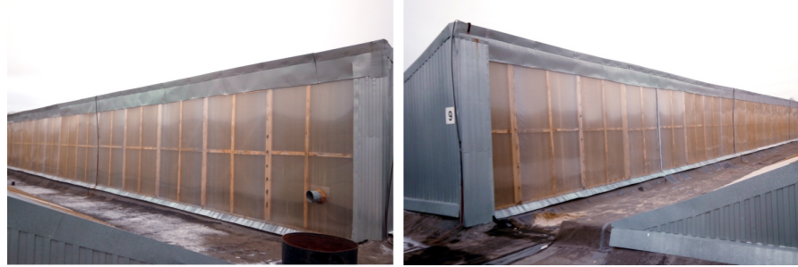
Рис. 15. Фрагмент устройства крыши типа «шед»
