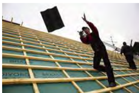
Abb. 7. Auf eine stabile Dachkonstruktion kommt es an
