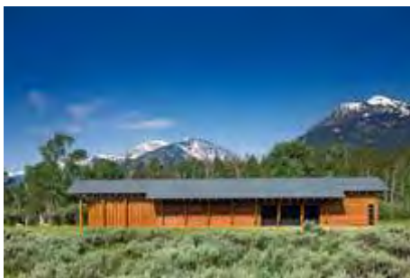
Abb. 8. Beim Hausbau sollte man auch auf Umwelt und Klima Rücksicht nehmen
