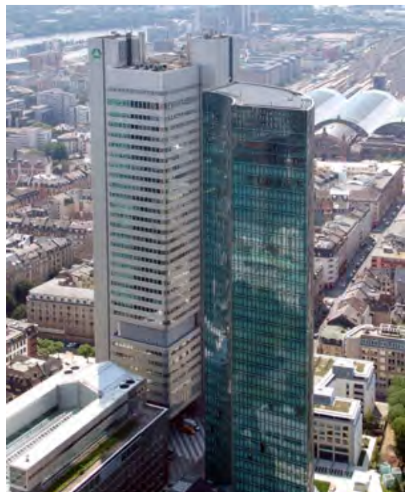
Abb. 21. Silver Tower; ABB Architekten; Foto: Michael Hierner / Emporis
