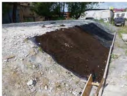
Рис. 2. Укрепление откоса геоматами МТ ЭКСТРАМАТ и МТД-ЭКСТРАМАТ с посевом семян (июль 2011г)
