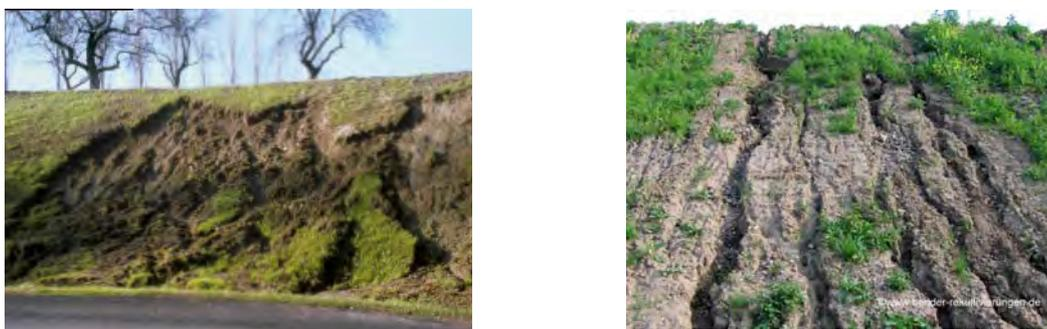
Рис. 1. Воздействие водной эрозии при отсутствии равномерного травяного покрова
