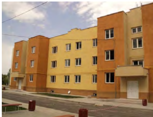
Рис. 4. Энергоэффективный многоквартирный дом в г. Волжский Волгоградской области [13]
