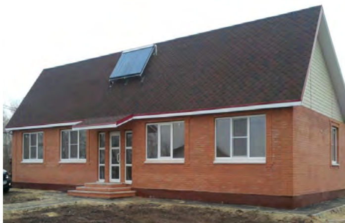
Рис. 2. Энергоэффективный жилой дом на 2 квартиры в х. Апаринский Ростовской обл. [13]
