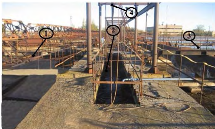
Рис. 1. Размещение предлагаемой фильтрационной перегородки на ГКОС о. Голодный, где 1 – первичный горизонтальный отстойник. 2 – распределительный канал аэротенка (предполагаемое место фильтрационного сегмента). 3 – аэротенк. 4 – кран балка.
