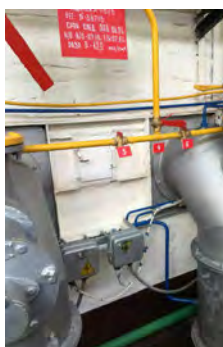
Рис.1.Точка отбора пробы №1, поверхность котла ДКВР
