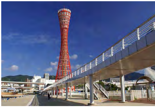
Рис. 1. Примеры гиперболоидных конструкций: а — Гиперболоидная башня в порту Кобе (Япония), б — Шуховская башня на Шаболовке (Москва)
