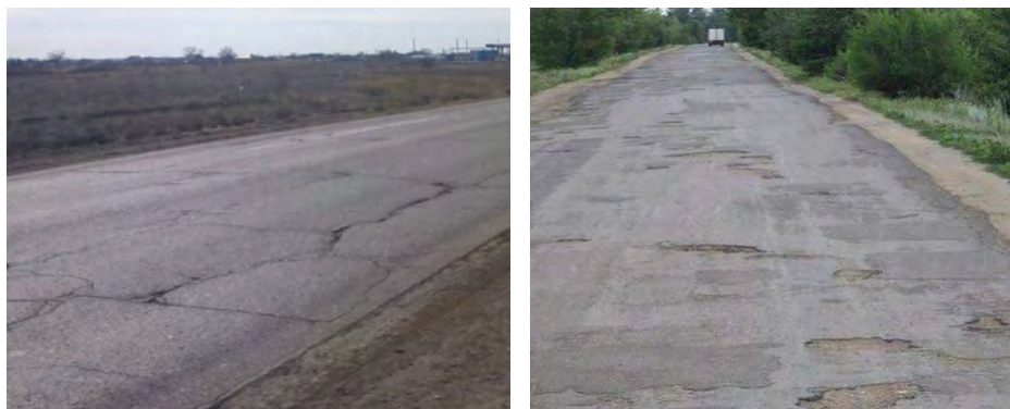
Рис.1 Дефекты на дорогах регионального или межмуниципального значения Волгоградской области
