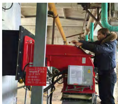
Рис.2. Точка отбора пробы №2, поверхность котла ДЕ (воздуховод)
