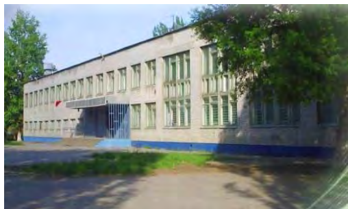
Рис. 1. Парадный фасад МОУ СШ №48 г. Волгограда до ремонта
